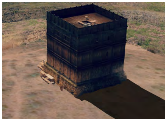
Fig. 5.1 – Vetricella (Scarlino, GR), ipotesi ricostruttiva della torre caratterizzata da un basamento in pietra (9x9 m ca.) e alzata in legno (ricostruzione grafica di Francesco Sala, progetto Erc-Advanced nEU-Med, UNISI, con modifiche).
