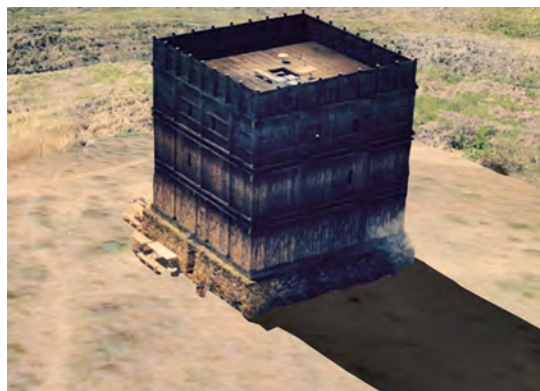
Fig. 5.1 – Vetricella (Scarlino, GR), ipotesi ricostruttiva della torre caratterizzata da un basamento in pietra (9x9 m ca.) e alzata in legno (ricostruzione grafica di Francesco Sala, progetto Erc-Advanced nEU-Med, UNISI, con modifiche).
