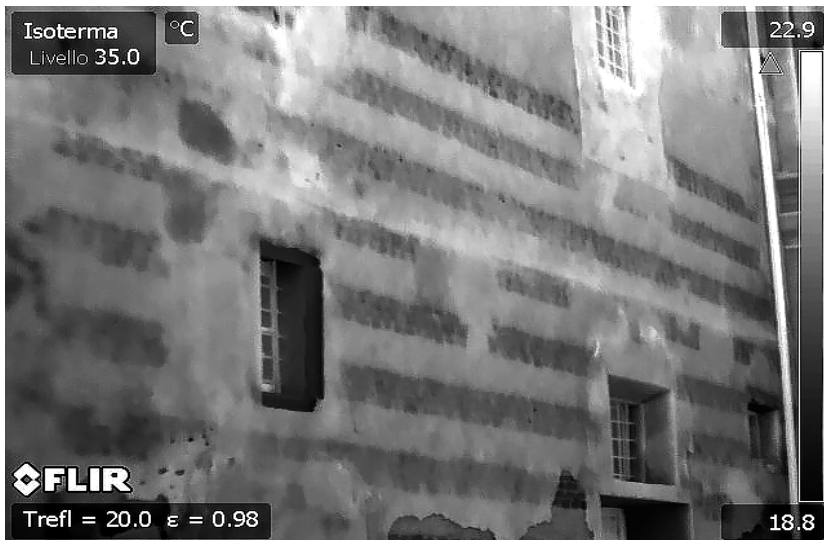
Fig. 5.5 – Roma, complesso dei SS. Quattro Coronati, termografia del prospetto in opera vergata (per gentile concessione di L. Barelli).
