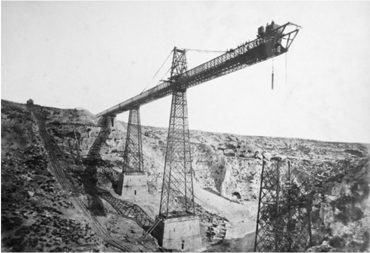
Alfredo Cottrau, Gran viadotto sulla gravina di Castellaneta in costruzione, Ferrovie Meridionali, 1868 (foto Achille Mauri, Archivio SIXXI).
